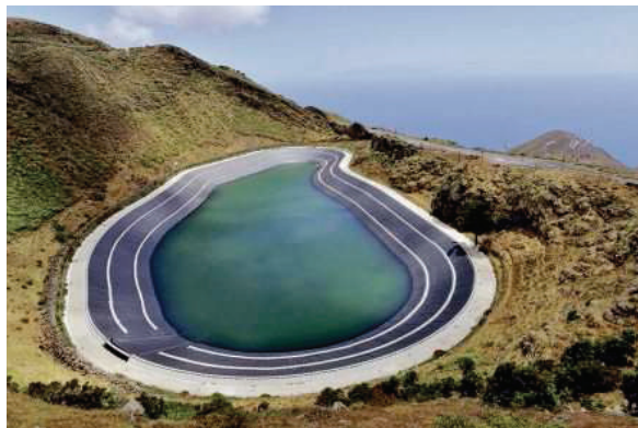
El Hierro gewinnt seine Energie vollständig aus Windkraft. Bei Flaute wird Wasser aus dem Stausee über Turbinen gejagt, um Strom zu produzieren. Vier Tage reicht der Speicher von 380.000 Kubikmetern Fotos: Lucas Vallecillos/WVPics/Redux/laif (li.), Gelmert Finol/dpa/EFE (re.)
